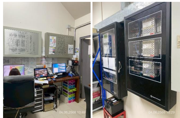
ภาพที่ 16 แสดงตู้ควบคุม/แผงควบคุมเพลิงไหม้
