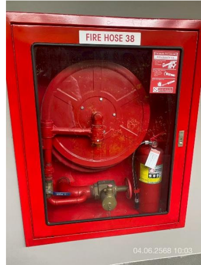
ภาพที่ 14 แสดงตู้เก็บสายน้ำดับเพลิง
