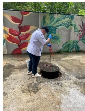
ภาพที่ 72 แสดงจุดเก็บน้ำทิ้งหลังบำบัด (Effluent)
